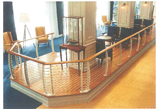
施工されたステンレス製ケーブル手すり
